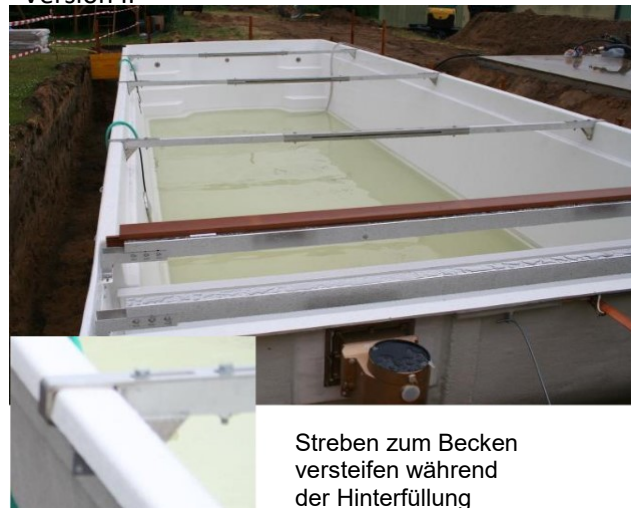
Abb. 7. - Einbauskitze der Seitenstützen zu den Schwimmbecken. Mit Hilfe der Seitenstützen kann nach Aushärten des Betons die Feineinstellung der Seitenwände leicht durchgeführt werden
