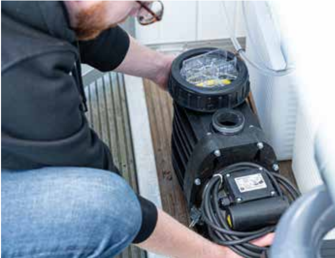
Schutz der Pumpe vor Regen / Spritzwasser: Von außen mag Ihre Poolpumpe gar kein Wasser, sollte dementsprechend in einem Technikraum / einer Technikbox untergebracht werden.
