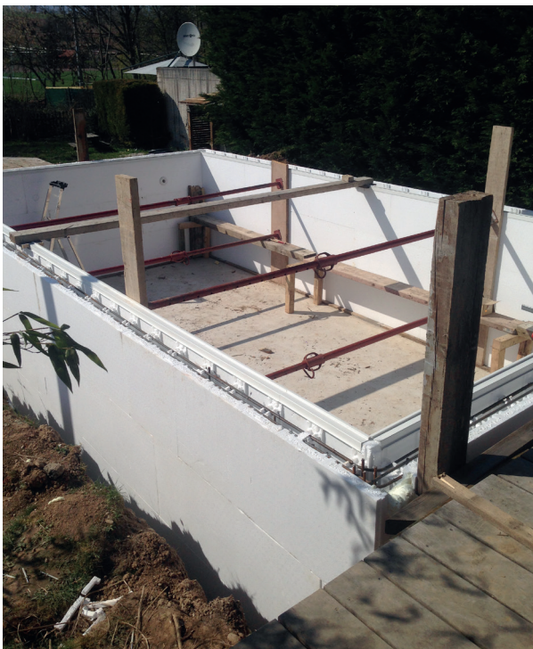
Versteifung der Poolwände vor der Befüllung
