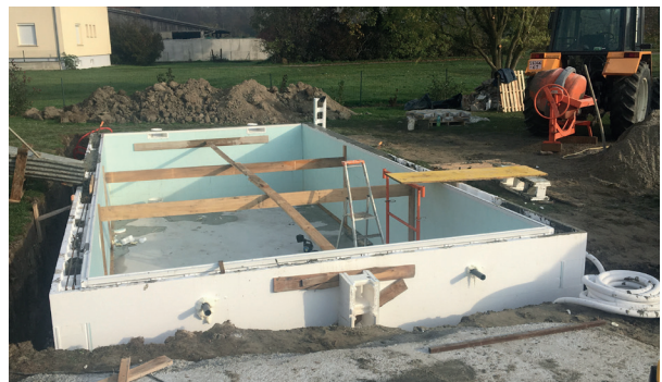
Versteifung der Poolwände vor der Befüllung
